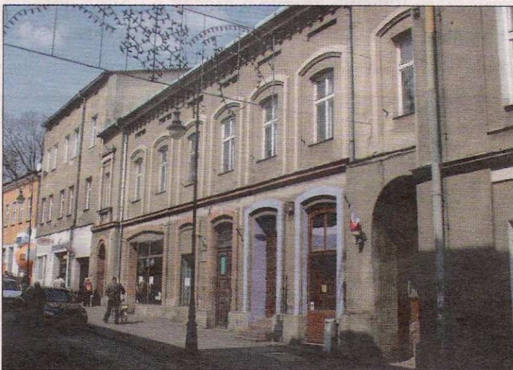
Ul. Mickiewicza w Chrzanowie. Kamienica nr 6 (pierwsza z prawej) oraz nr 8 (następna) zostaną przebudowane na mieszkania komunalne. Na parterach pozostaną lokale usługowo-handlowe.
